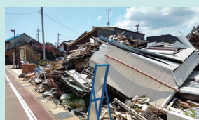
能登地震の被災現場
